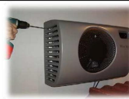
Установить крышку кондиционера Winemaster на прежнее место и затянуть 4 винта.
