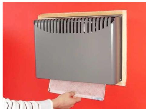
Поднимите выемку и удалите фильтр из-под кондиционера. Для вставки нового фильтра повторить эти же действия в обратном порядке.
